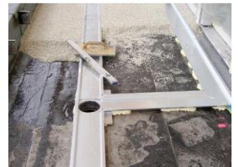
Gefälleherstellung unterhalb der zu verlegenden Dämmung.
