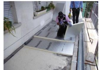
Gefälleherstellung unterhalb der zu verlegenden Dämmung.
