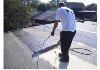
Abdichtungslage im Gieß- und Einrollverfahren verlegt.
