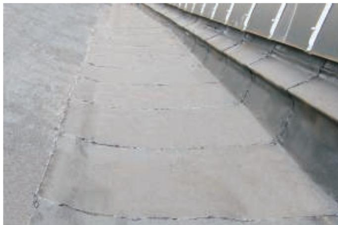
Sheddach, Anschluss mit Fensterbank aus Zinkblech
